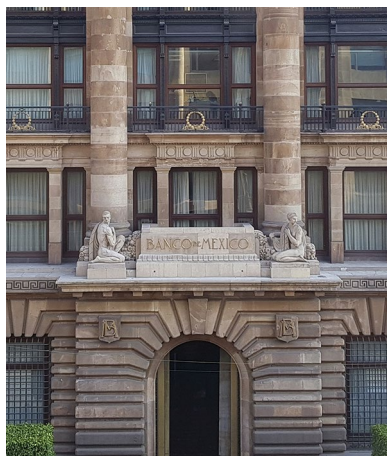
Edificio Principal de Banco de México en el Centro Histórico de la Ciudad de México
